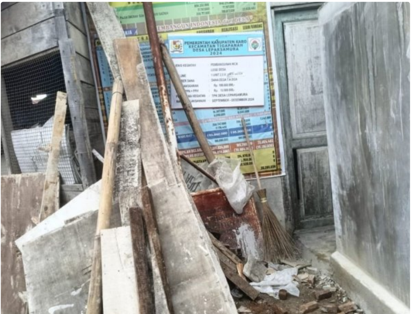
Potret Bangunan MCK di Desa Lepar Samura, Kecamatan Tigapanah yang 'Telan' Dana Ratusan Juta Rupiah
